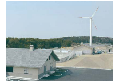
＜風力発電＞(静岡県掛川市)
