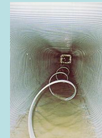
（非開削の更生工法）
