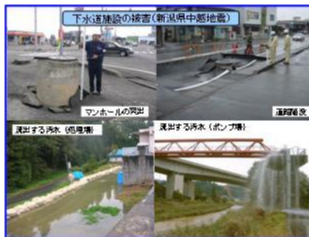
図IV-2-1 新潟県中越地震による下水道施設の被災状況
