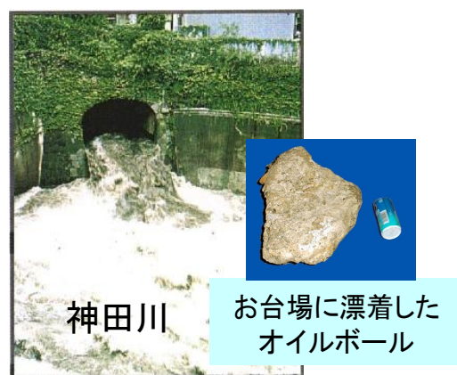
図IV-4-3 未処理汚水の放流状況
