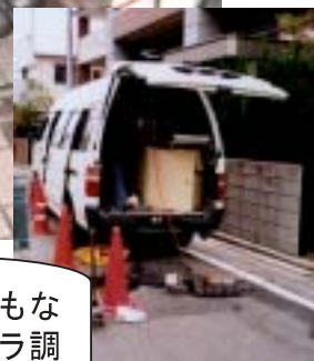
老朽管渠を調査するTVカメラの搬入状況
