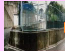
従前の防災調整池
