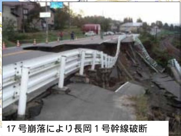
17号崩落により長岡1号幹線破断
