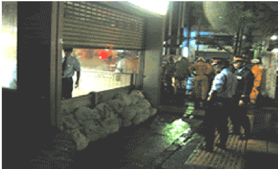
図5 - 9 浸水時の土のう設置(例)
