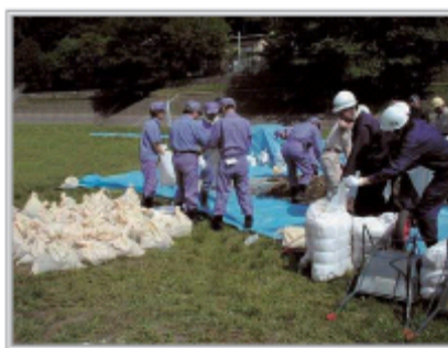
図5 - 10 簡易水防工法および土のう積み訓練（例）
