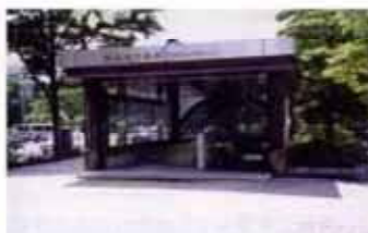
仙台市営地下鉄 勾当台公園駅
