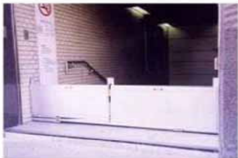
▲仙台市営地下鉄 五橋駅
