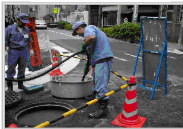
図 1 - 2 0 管きょ・ポンプ場の点検、清掃作業 ( 例 ) 資料：東京都ホームページ
