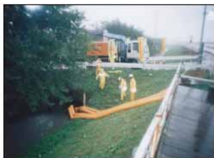
可搬式ポンプによる排水(資料:仙台市)
