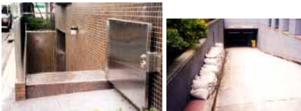
図1 - 37 地下室・地下駐車場への止水板・土のう設置の事例（例） 資料：広島市ホームページ
