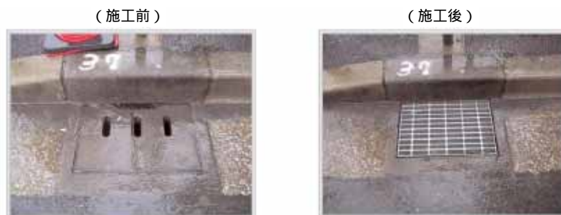
図 1 - 16 道路雨水ます蓋のグレ - チング蓋への取替え 資料：東京都ホームページ
