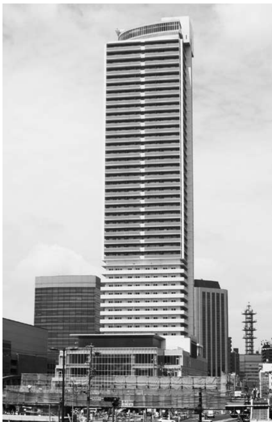
建設中の岐阜シティ・タワー 43
