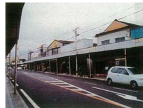
アーケード撤去前の商店街の様子
