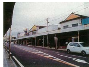
アーケード撤去前の商店街の様子
