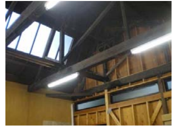
屋根の採光窓
