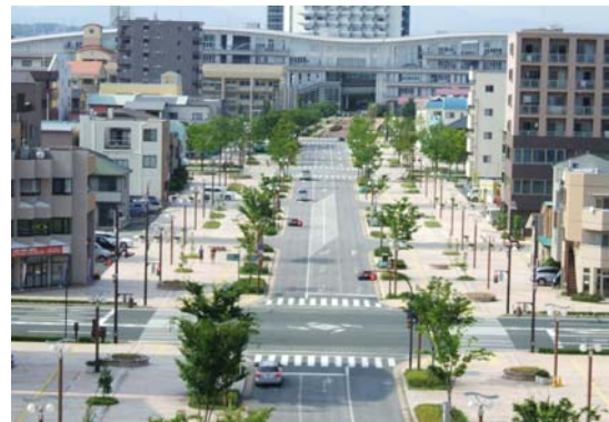
学園通り（東6号線）車道はインターロッキング、歩道は自然石で舗装され、広幅員の歩道は子どもたちの安全な通学を守っている。
