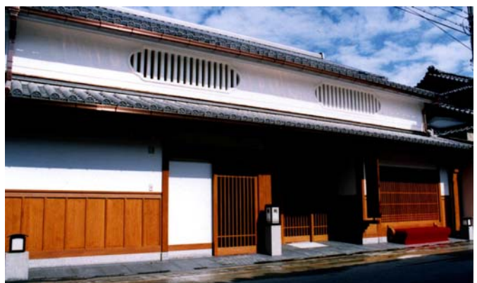
平成9年度市により開設された「まちづくりの館」。集会施設として建築され、まちづくり活動の拠点として活用されている。またトイレやロビーは一般開放されている。
