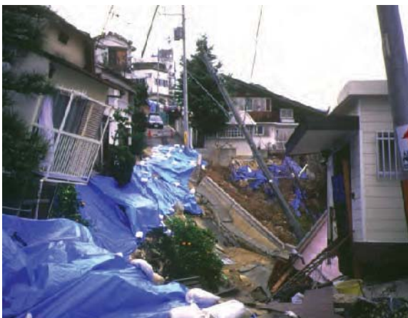
■阪神・淡路大震災による被災状況
