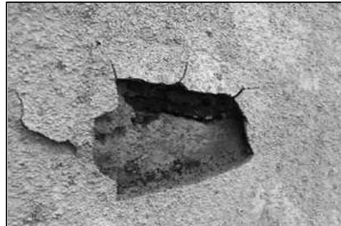
鉄筋の腐食
