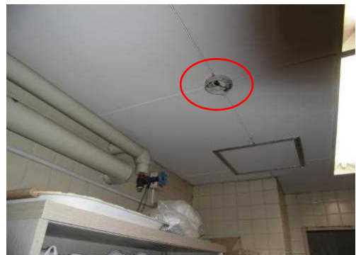
撤去されたまま放置されている火災報知器
