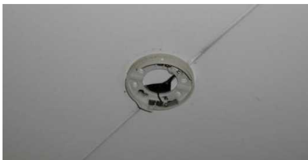
撤去されたまま放置されている火災報知器
