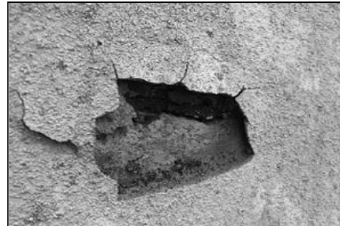
鉄筋の腐食
