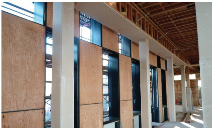
耐火被覆施工状況
