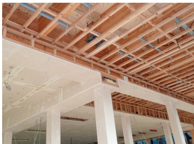
耐火被覆施工状況（天井部）
