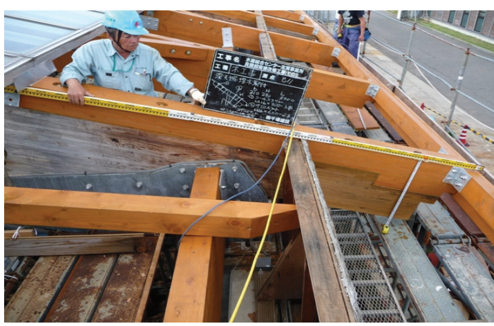
補修完了状況
