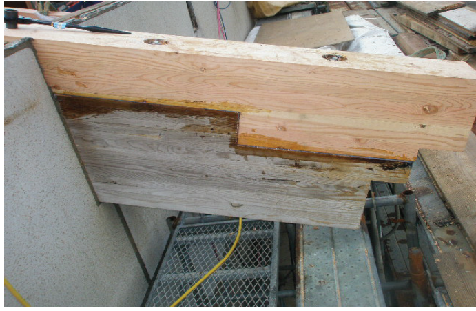
埋木取り付け状況
