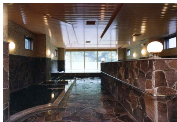
▲浴室に設けられた手すり：洗い場、浴槽内及び出入口に設置
