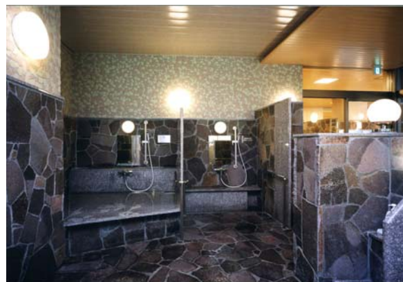
▲車いす使用者用（左）、高齢者用（右）のシャワーブース
