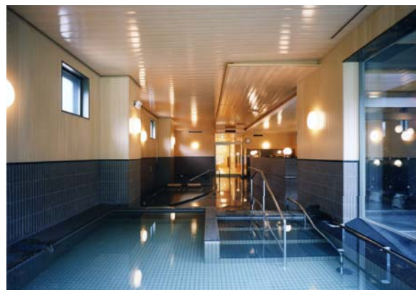
▲浴室に設けられた手すり：洗い場、浴槽内及び出入口に設置
