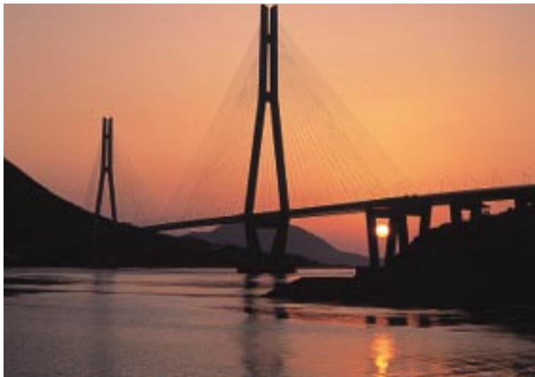
多々羅大橋
