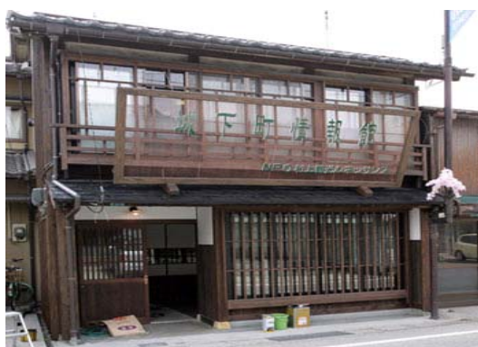
再生町屋を利用した観光案内所 ▶ (新潟県村上市)
