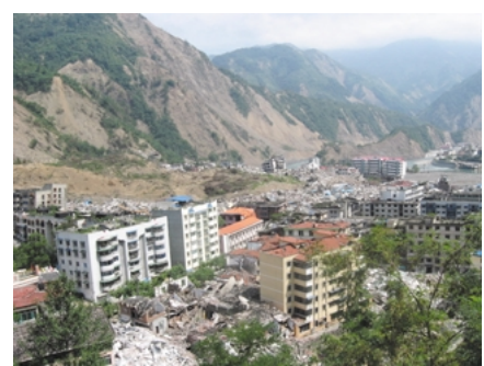
土砂崩落による集落被害の様子
