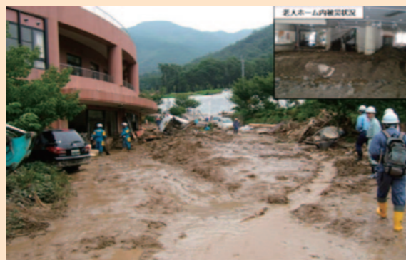
防府市真尾地区（特別養護老人ホーム）被災状況
