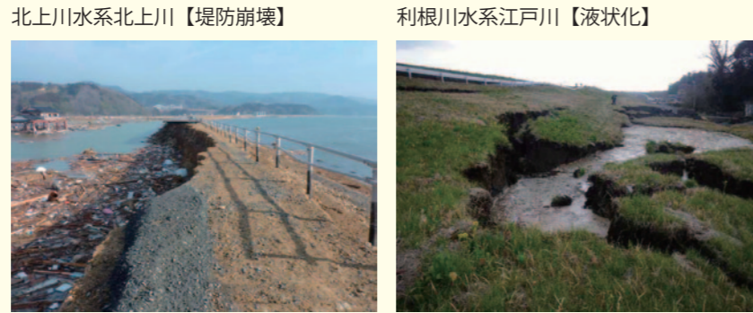
図表34 東日本大震災における河川の被害状況
