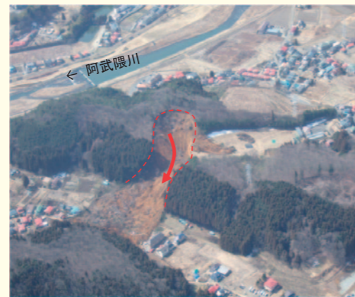
東日本大震災における土砂災害の発生状況（福島県白河市葉ノ木平）
