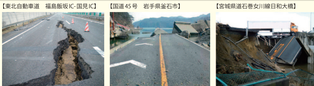
図表36 東日本大震災における道路の被害状況
