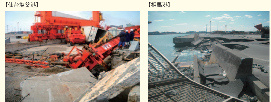
図表39 東日本大震災における港湾の被害状況
