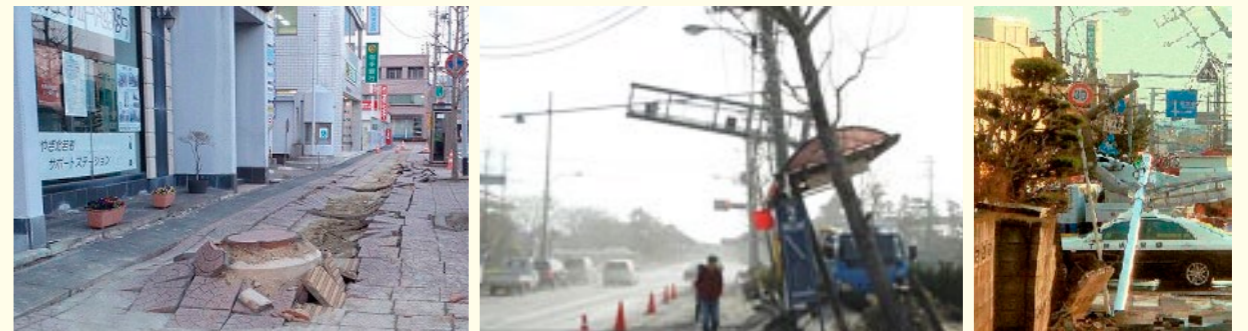
図表29 東日本大震災における液状化被害の状況
