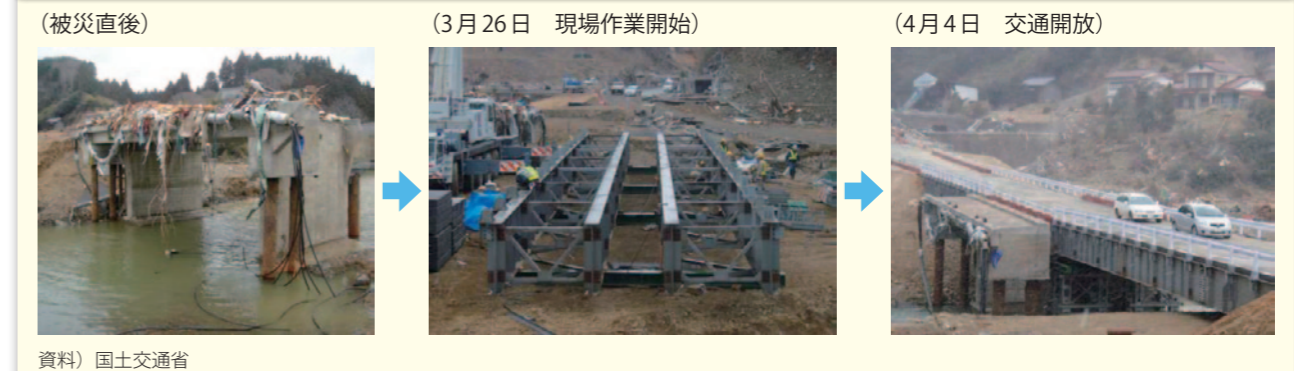
図表59 道路の応急復旧状況 (国道45号二十一浜橋 (宮城県気仙沼市))
