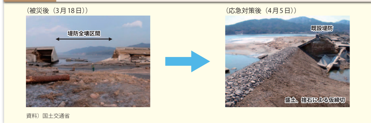
図表54 海岸堤防の応急復旧状況（岩手県宮古市）
