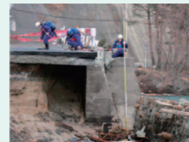
【被災状況調査】
