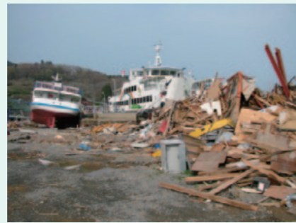
【大島の被災状況】
