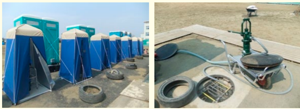
図表72 避難所で活用されたマンホールトイレ
