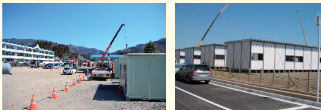
図表73 応急仮設住宅の建設状況
