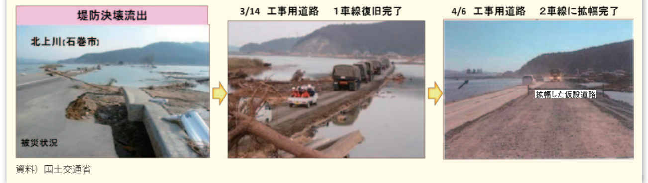
図表55 河川堤防の復旧状況
