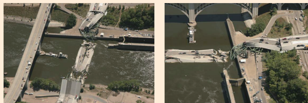
図表 153 ミネソタ州ミネアポリスの橋梁崩落事故（2007年）
