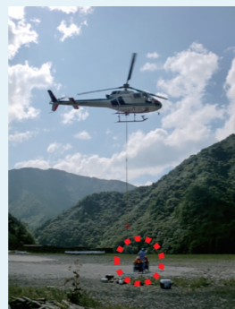
投下型水位計の設置状況
