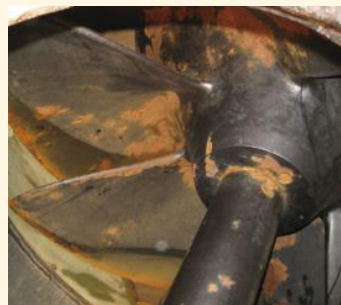
ポンプ設備のインペラ
