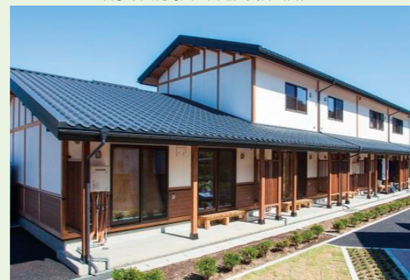
岩手県大槌町大ケ口地区災害公営住宅
