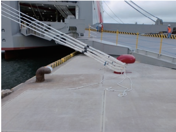
整備された係船柱（右） （左は既設の係船柱）
