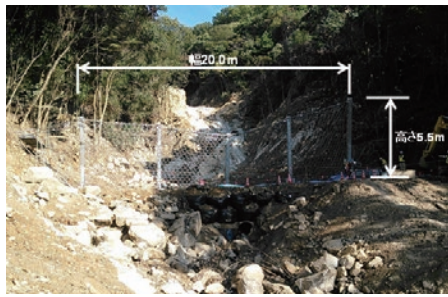
強靱ワイヤーネットの設置
