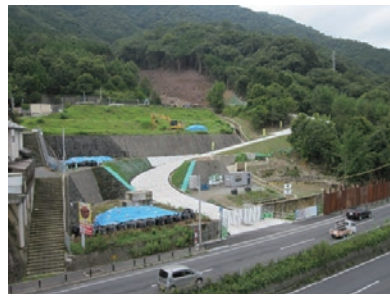
工事用道路の整備
