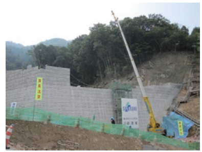
砂防堰堤の立ち上げ
