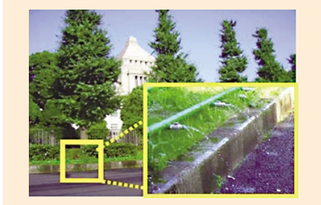
下水処理水を活用した道路散水
