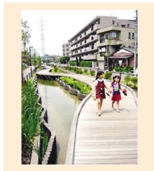
下水処理水を活用したせせらぎの再生（神奈川県川崎市）
