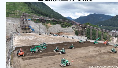
自動施工の状況
