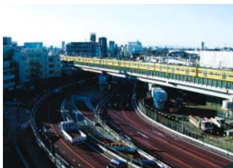
西武鉄道池袋線（練馬～中村橋間）目白通り付近の状況
