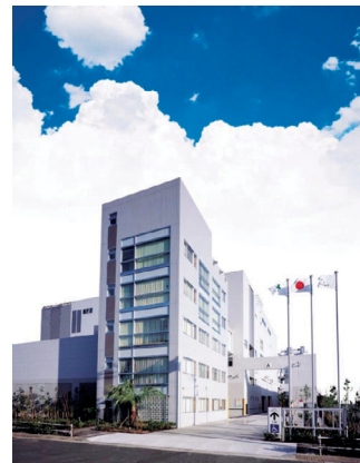
平成16年12月に稼働した建設混合廃棄物リサイクル施設
