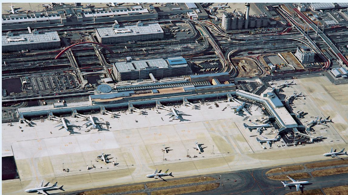
上空から見た第2ターミナル
