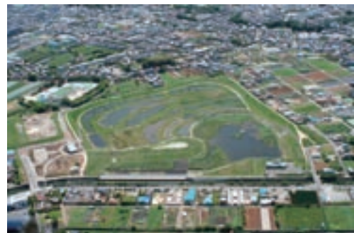
図表 2-4-2 大柏川第一調節池緑地の外観
