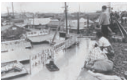
図表 2-5-10 昭和22年カスリーン台風被災状況（東京都葛飾区）
