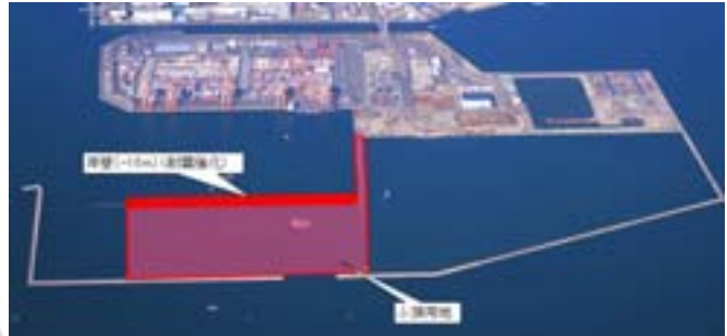
図表 2-6-2 横浜港南本牧ふ頭地区
