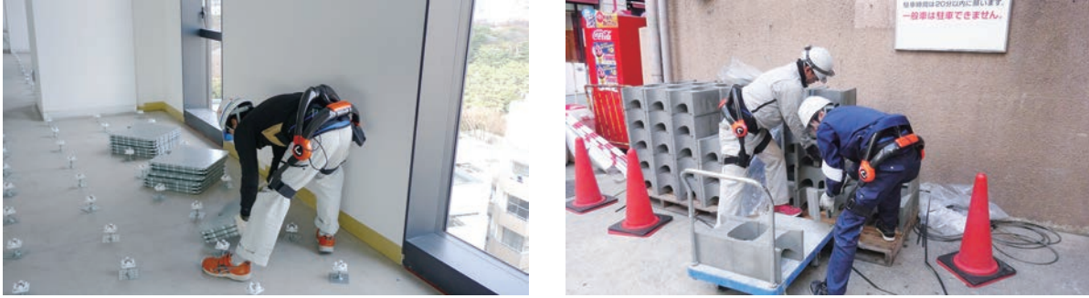
図表1-3-6 装着型ロボットの現場実証事例
