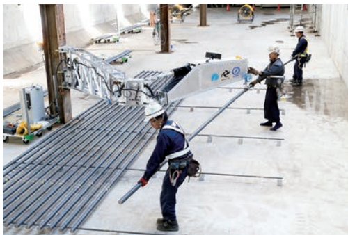
図表1-3-5 配筋アシストロボと構造概念図
