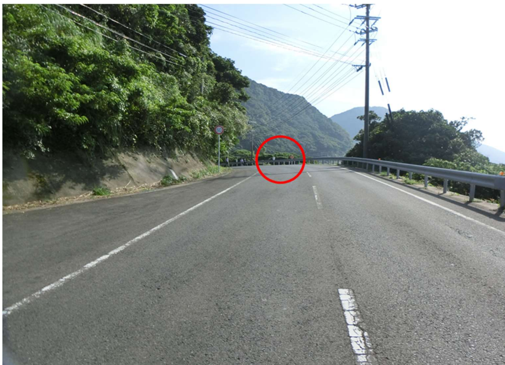
写真4 事故地点手前から事故地点（○部分）を望む
