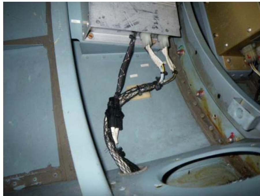
写真8 配線の状況(同型機)
