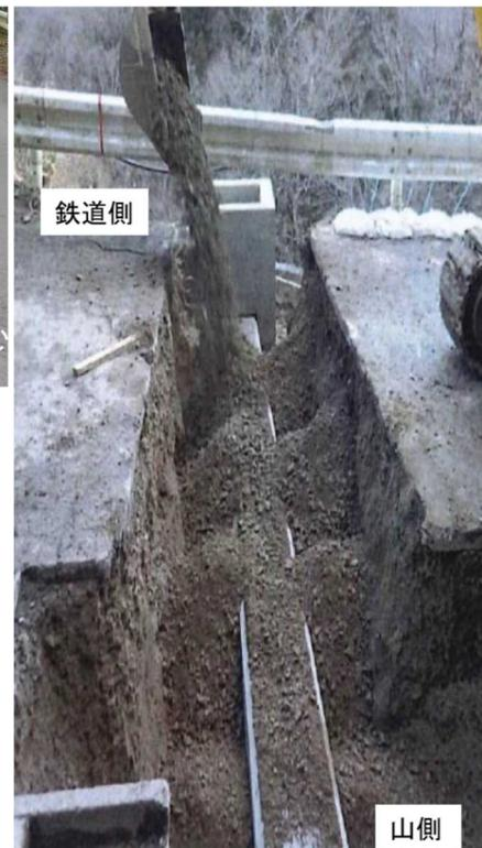
図9 新たに設置した水路
