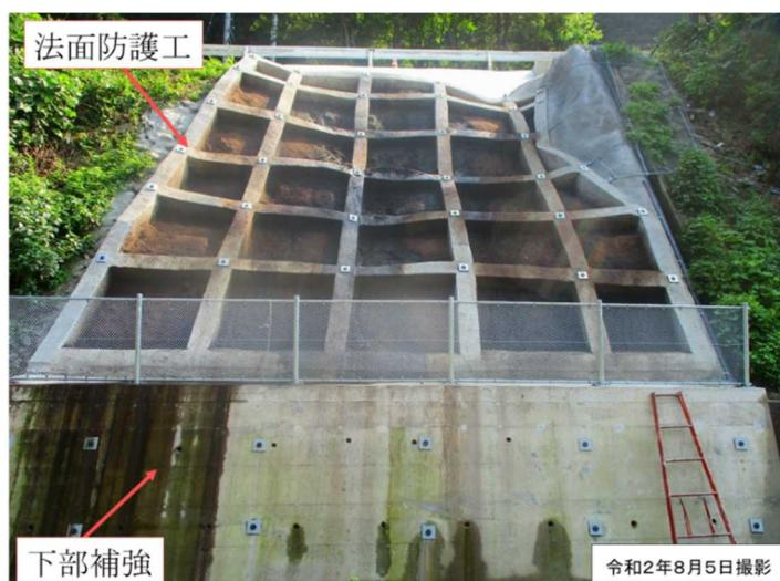
図10 法面防護工の実施状況
