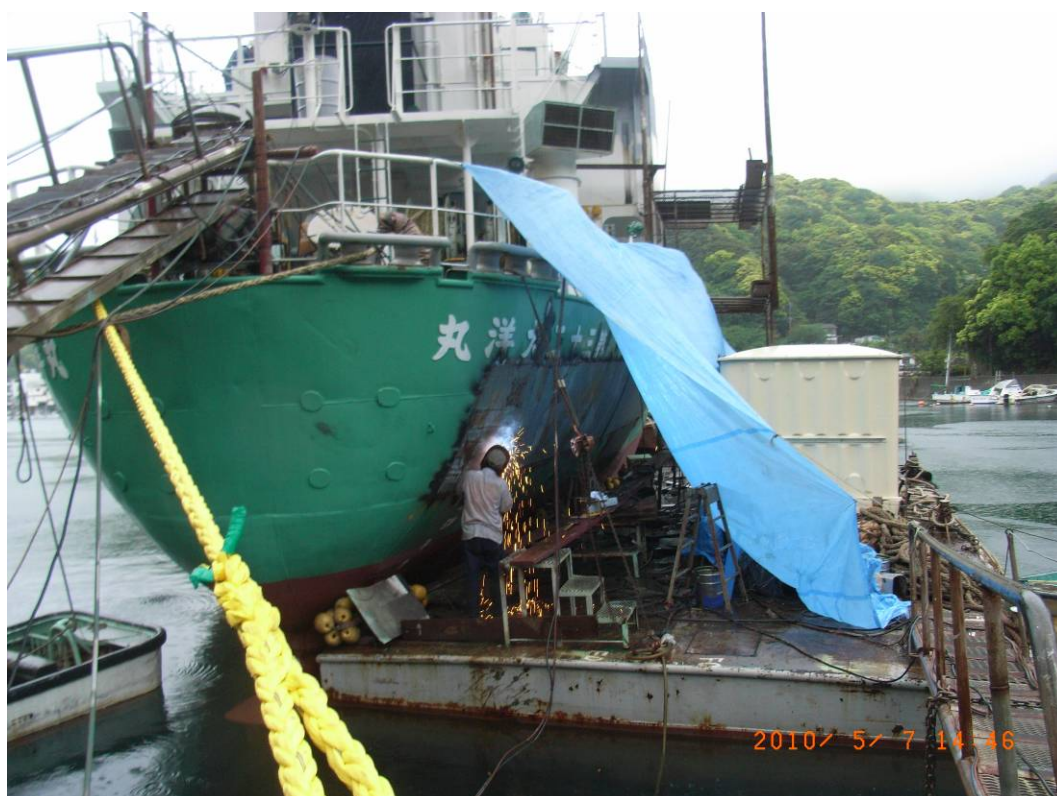
写真2 A船損傷部の修理状況
