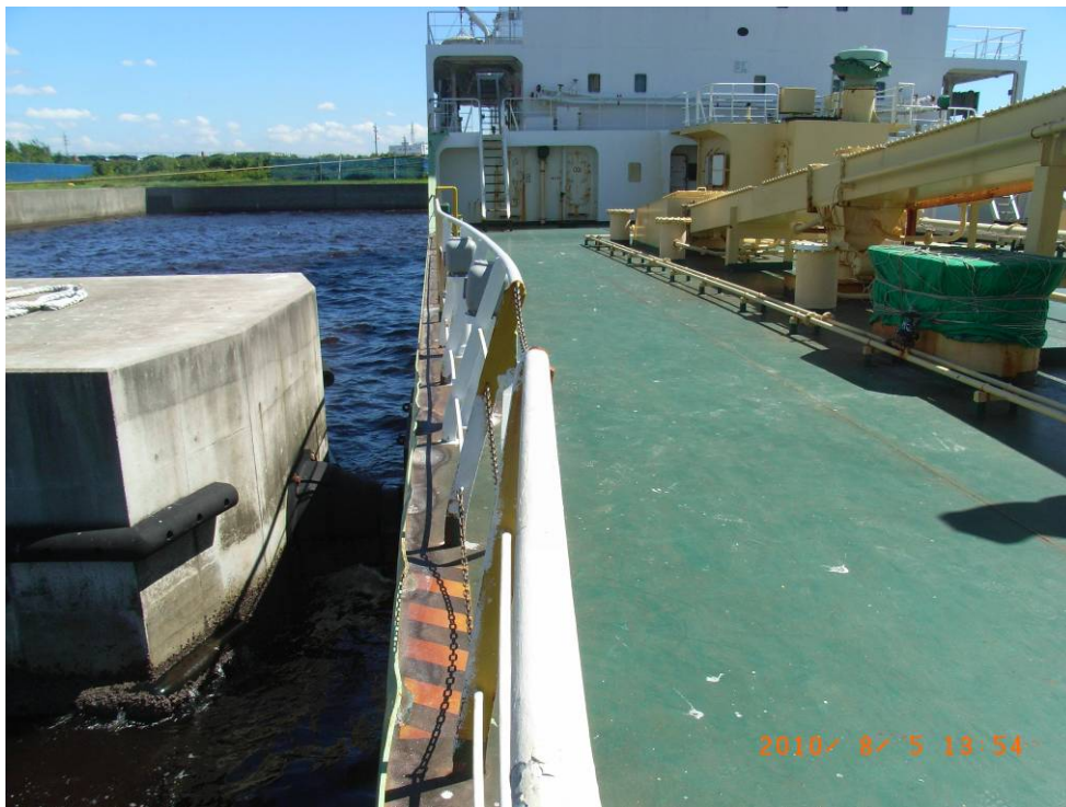
写真 1 1 B 船の損傷状況（中央部その 2）
