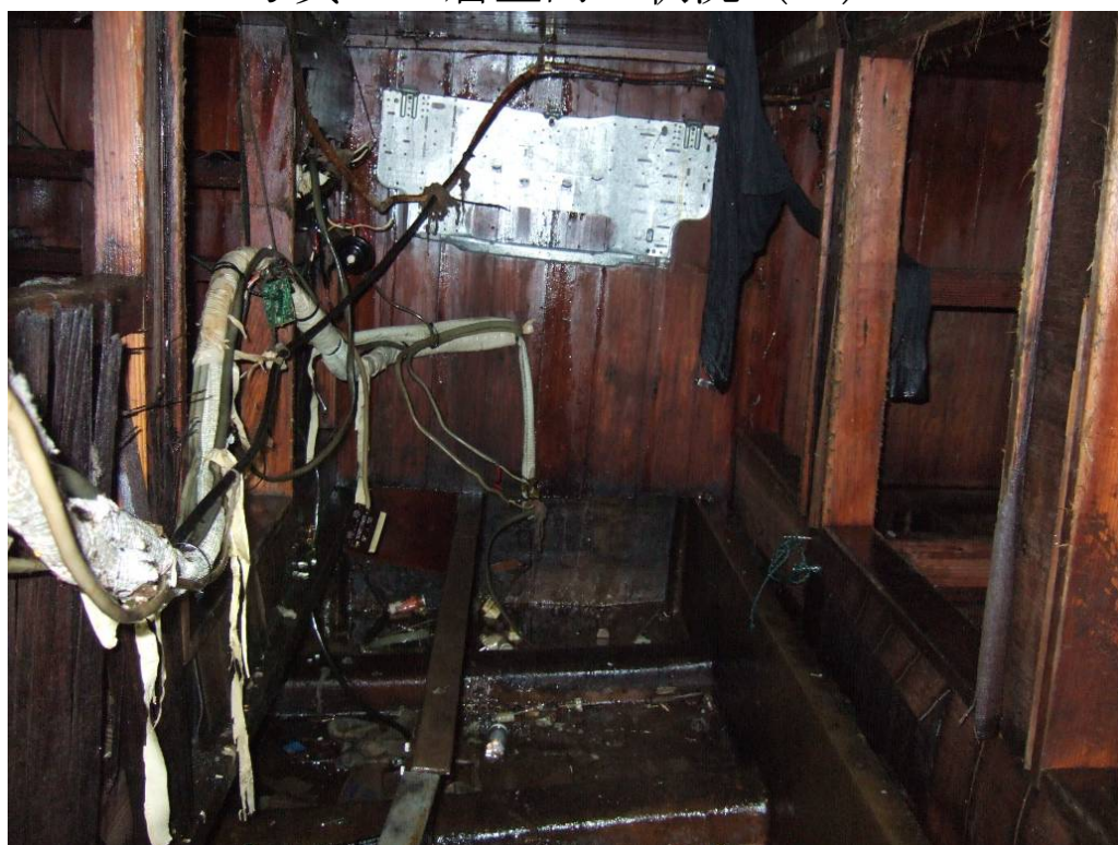
写真7 居室内の状況 (2)
