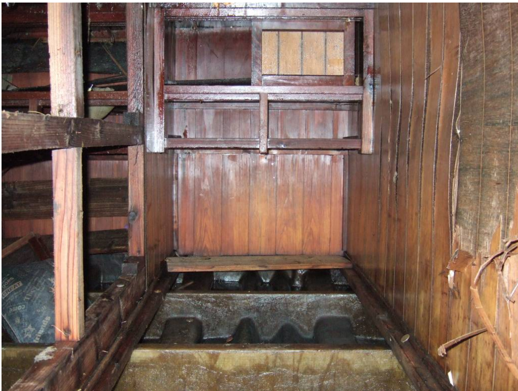
写真6 居室内の状況（1）
