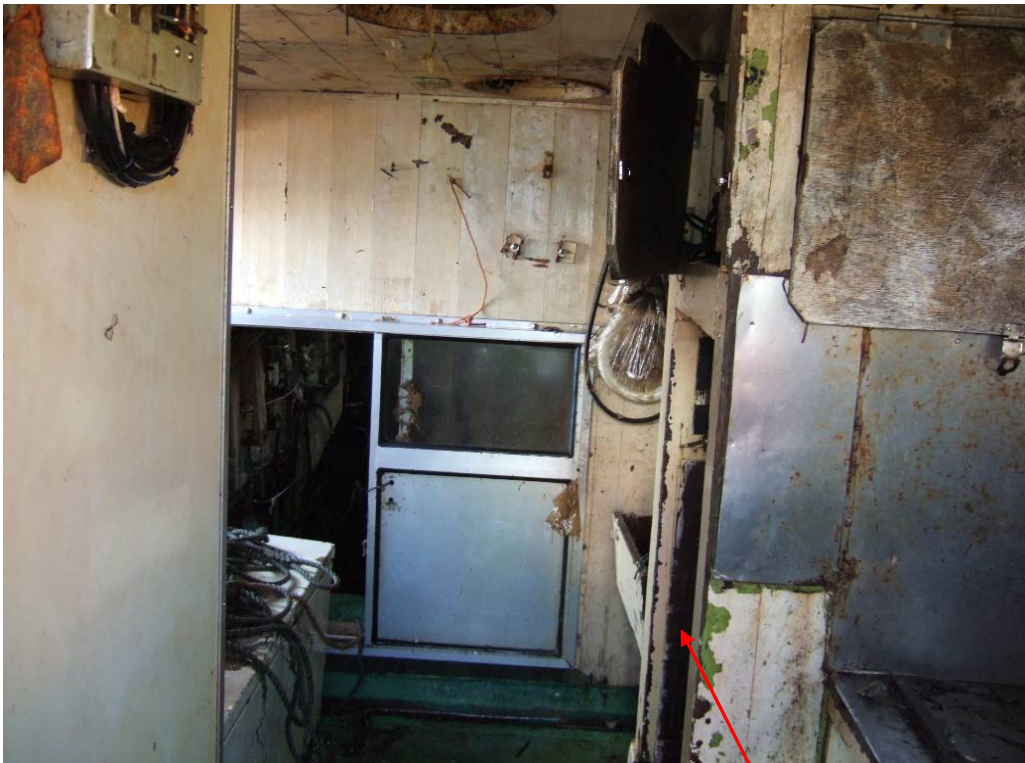
（機関室方向を見る）
