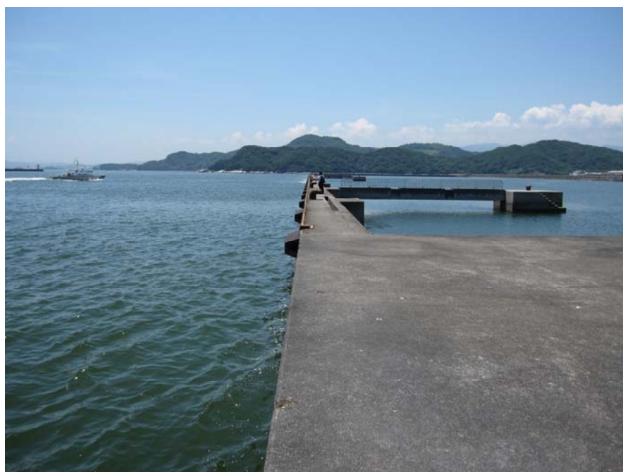
写真4 係船杭の状況
