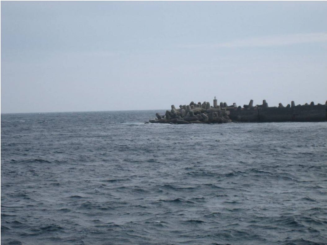
写真 6 消波ブロックの損傷状況①
