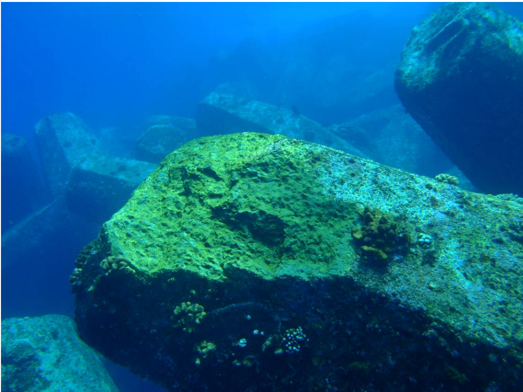
写真 6 消波ブロックの損傷状況①
