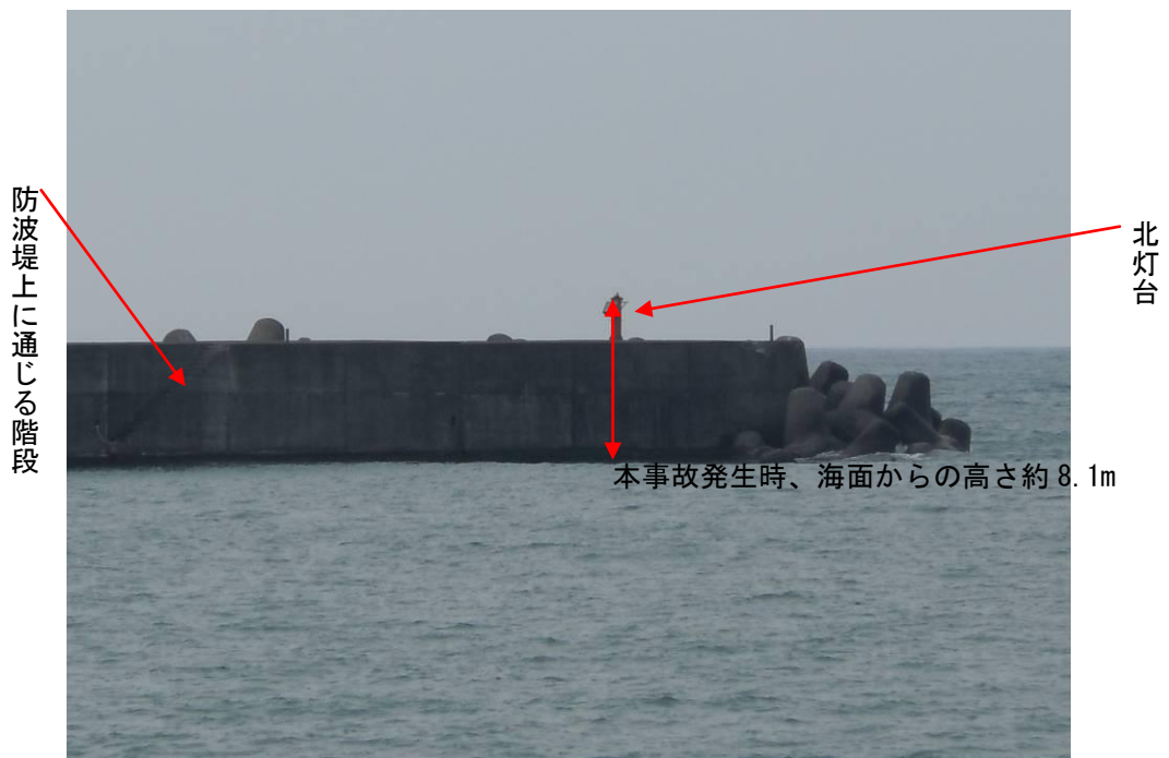
写真3 本件防波堤及び北灯台
