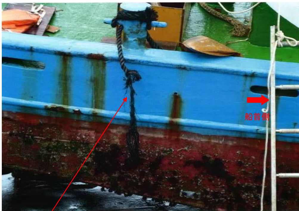
破断した右舷側の連結ロープ
